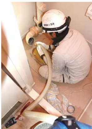
マンションのトイレで 手際よく作業を進める
