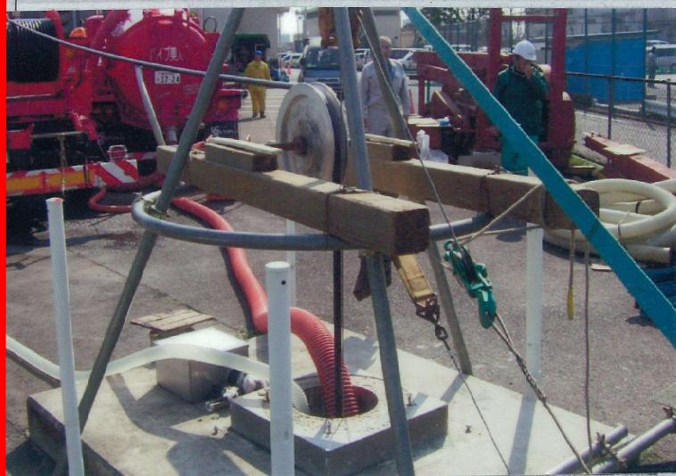
さく井工事、管更生・洗浄等のパイプ美人(福井市菅谷2丁目)鈴木健治代表取締役)は、長年使用された井戸の地下水を復元させる洗浄技術の普及に力を注いでいる。従来、井戸の修繕復旧作業は掘削時に使われるやぐらを組み立て、ワイヤーブラシ等の水摩擦洗浄や薬品洗浄などを行っている。しかし、これら
